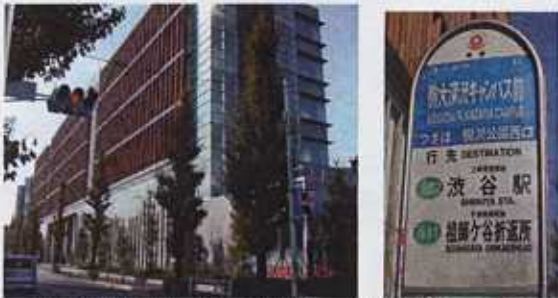
駒沢公園側より深沢校舎を撮影 校舎正面にバス停あり
